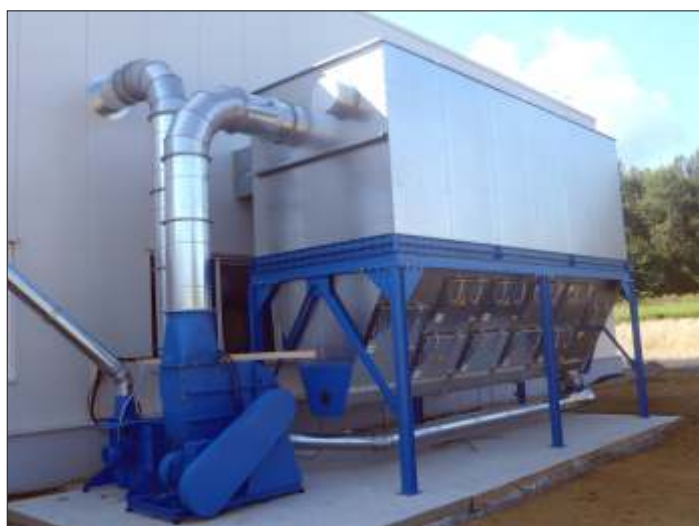
• Filtry FZŠ-H-B6 instalované ve firm SGA Schody Kaplice
